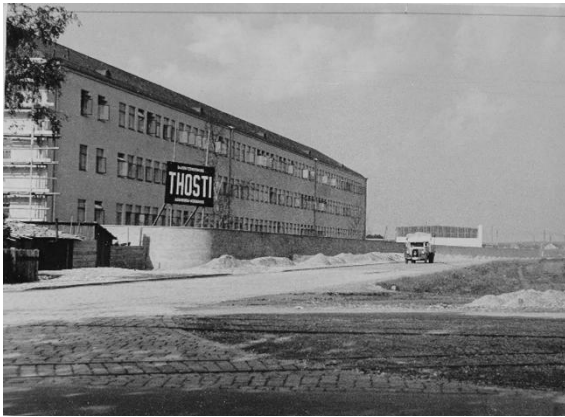
Die Konstruktionsbüros an der heutigen Werner-von-Siemens-Straße mit Bauschild der Augsburger Baufirma Thosti. Im Hintergrund die Einfloghalle.
